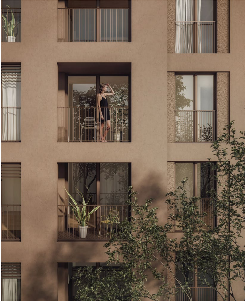
Private Außenbereiche: Loggien
